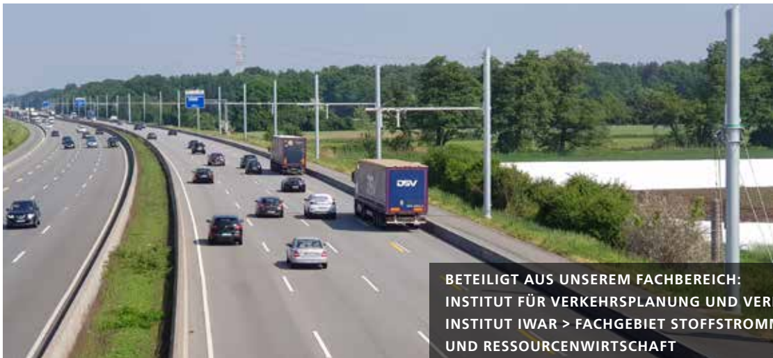
FERTIGGESTELLTER ABSCHNITT AUF DER A5 completed track section (source and copyright: Hessen Mobil)
